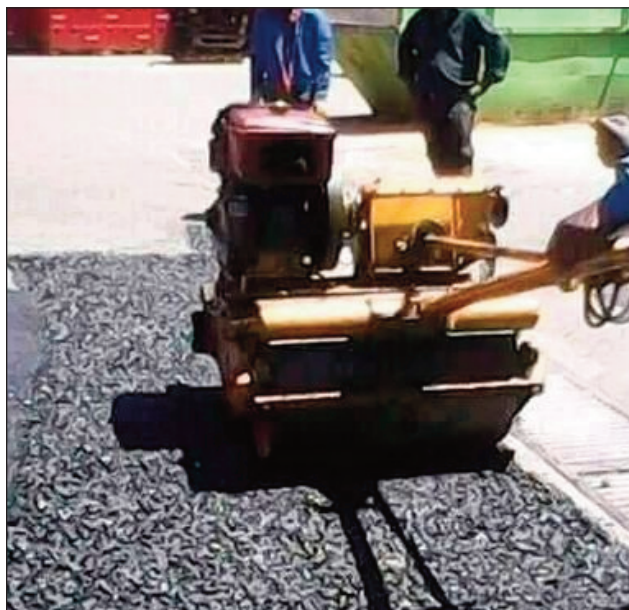
Ny fanamboaran-dalana any amin'ny kaominina Ivato Ambohidratrimo.
